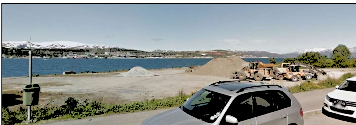
III 7.8 Fjernvirkning fra Tomasjordneset. (fotogrunnlag google streetview)
